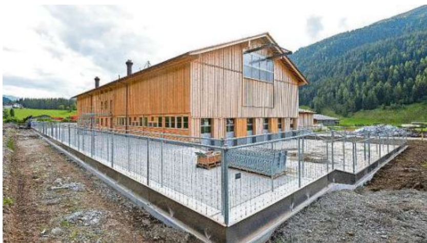
Energetisch mit Biogasanlage versorgt: Der neue Schafstall des Davoser AO-Zentrums ist bezugsbereit.
